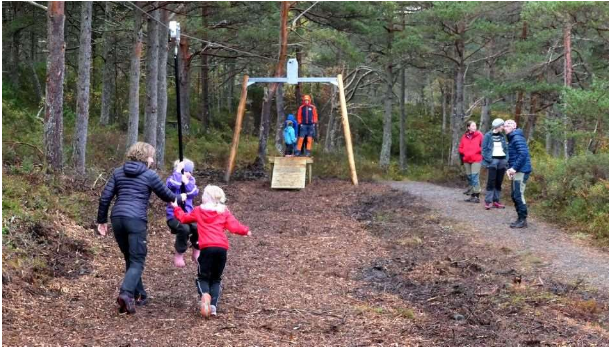
Figur 10 Zip-linen er ferdig!
