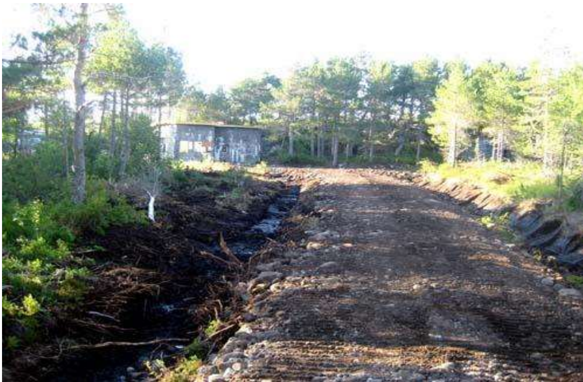
Figur 1 Nylagt vei fram til Museumsbunkeren
