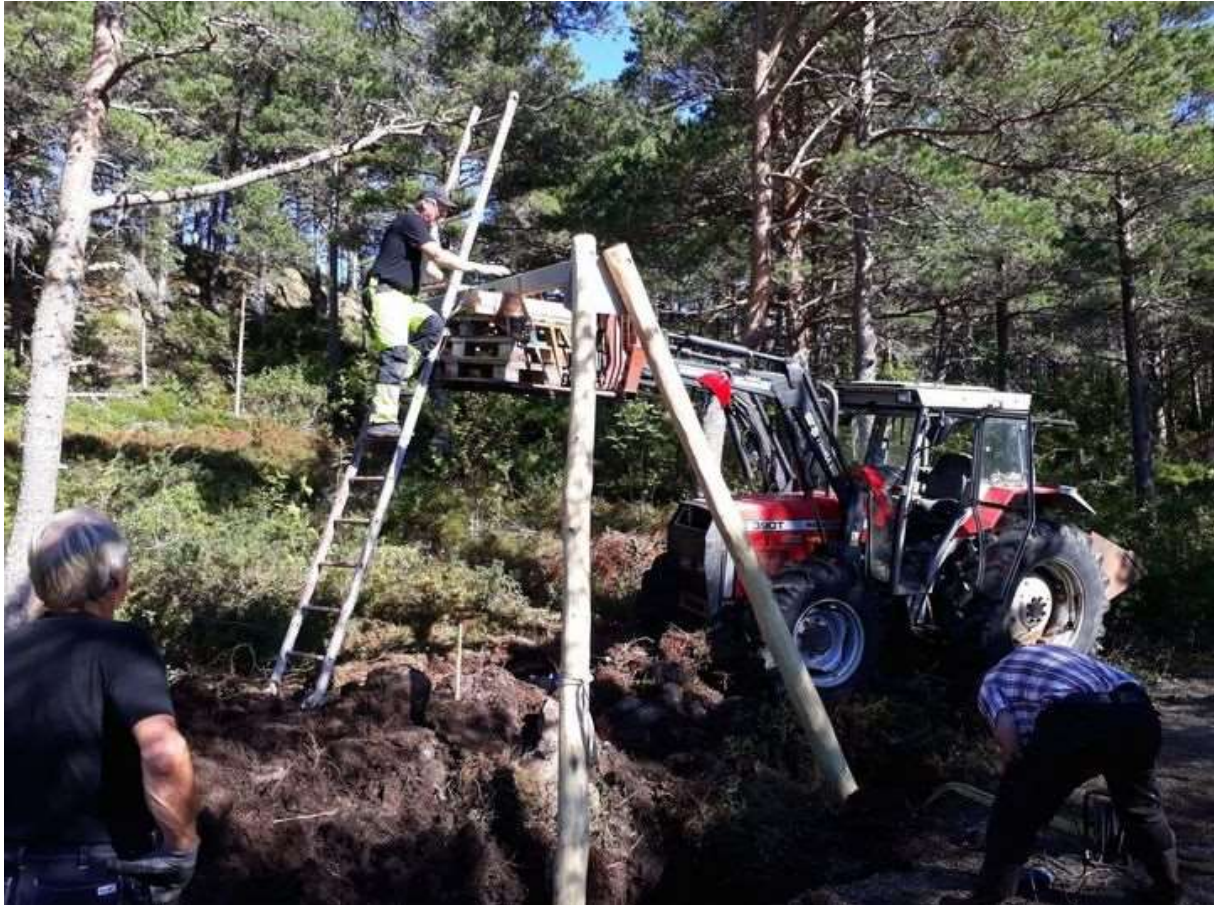
Figur 9 Zip-line blir montert.
